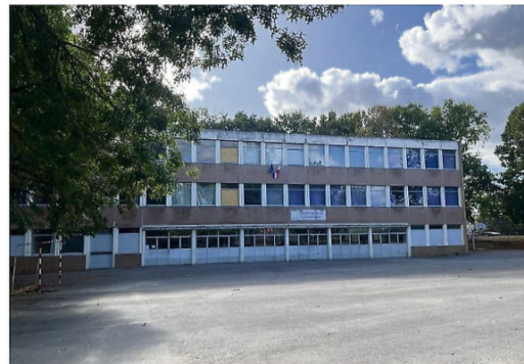
L'élémentaire Gérard-Philippe n'accueillera pas de bureaux de vote pour les prochaines élections. Pour cause, les travaux de réhabilitation vont commencer. PHOTO M. ROGERIE
