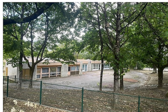
La maternelle Marcel-Proust, située à l'angle de la rue Rhin-et-Danube et de l'avenue de Beaubreuil, n'accueille plus d'élèves. Elle devrait être démolie dans les prochains mois. PHOTO MARYLINE ROGERIE
