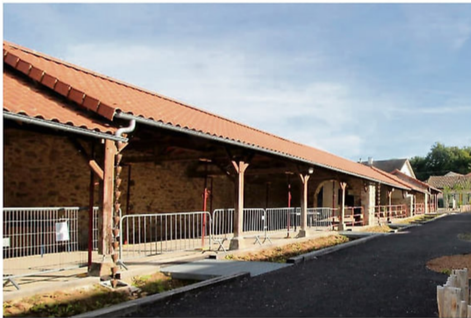
Des échafaudages pour soutenir les préaux et des barrières pour interdire l'accès.
