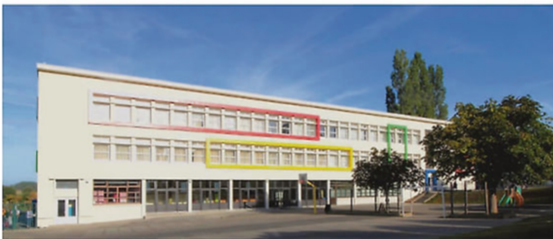
Une école rénovée avec sa nouvelle façade.
