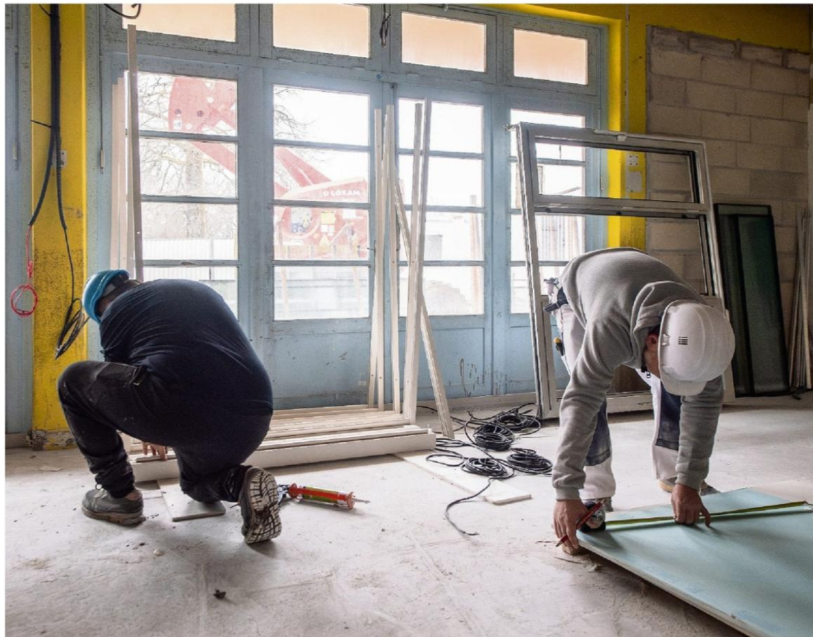
Chaque année, de nombreux travaux sont annoncés dans les écoles de Limoges. Des travaux de menuiserie ont été ainsi menés ici dans l'école Jean-Montalat dans le quartier de
